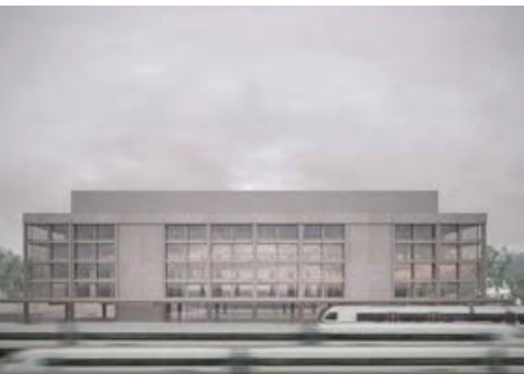
Der geplante Neubau bietet einfach zu organisierende, flexibel erschliessbare Räume und somit Raum für moderne Arbeitsformen.
